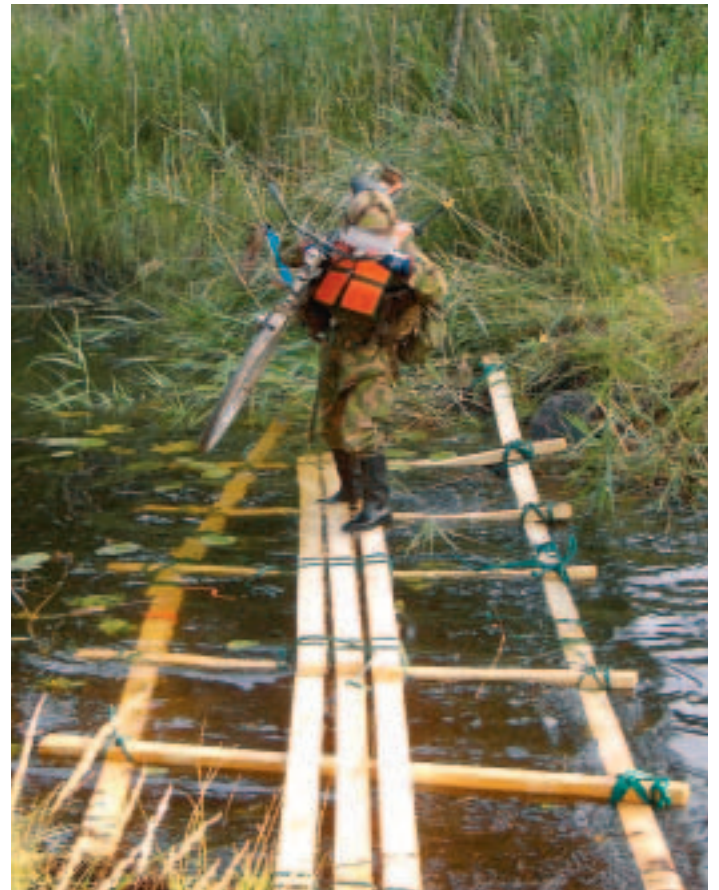
Pikasillan rakennusrastilla: Kuva: Esko Vaahtolammi.
